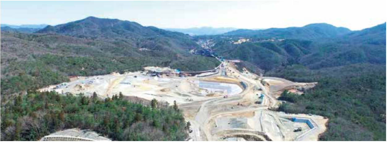
切畑トンネル作業所遠景
