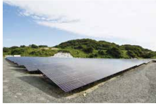
パネル設置状況
