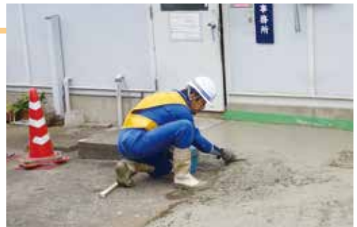
車いす用スロープ通路の施工
