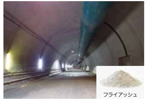
フライアッシュを利用した中流動コンクリート施工状況
