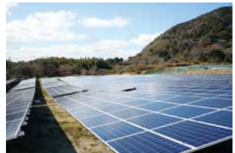
傾斜地でも影がでにくい架台(光メガソーラー作業所)
