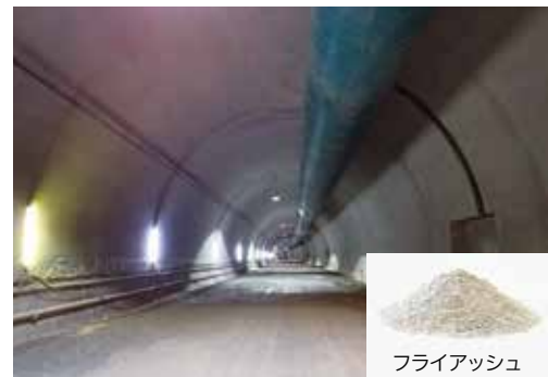
フライアッシュを利用した中流動コンクリート施工状況
