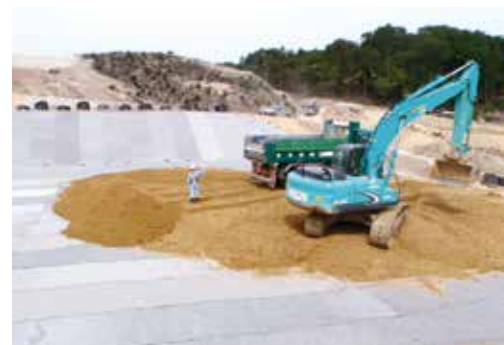
採石場の脱水ケーキを利用した改良土での保護層施工状況
