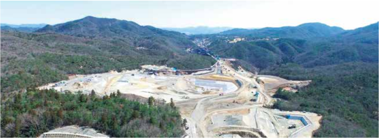
切畑トンネル作業所遠景
