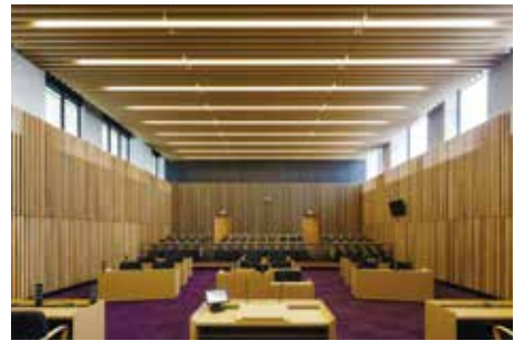
国産木材のルーバー(黒部市庁舎作業所)
