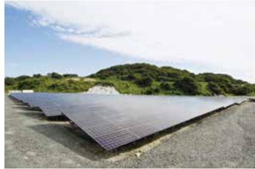
パネル設置状況
