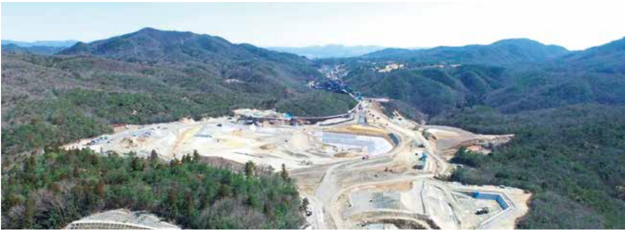
切畑トンネル作業所遠景
