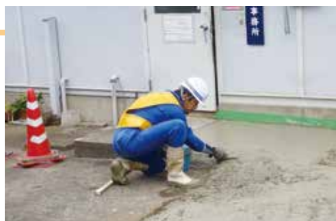
車いす用スロープ通路の施工
