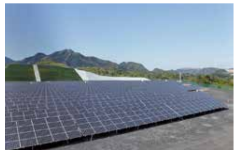
太陽光パネル設置状況
