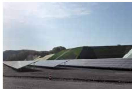
当社開発技術を採用した架台 (美称メガソーラー作業所)
