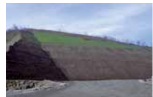
緑化吹付作業完了
