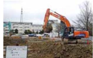
ハイブリッド重機の採用によるCO<sub>2</sub>削減
