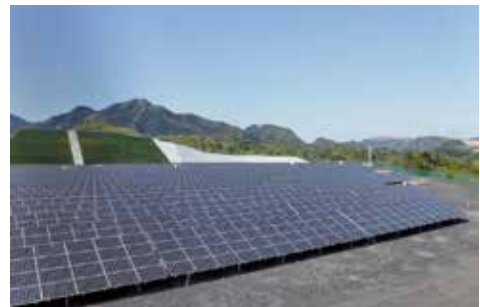
太陽光パネル設置状況
