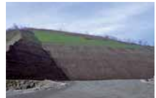
緑化吹付作業完了
