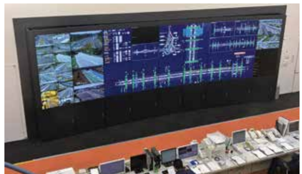
情報を一元化し、一目で道路状況を把握できる「管制室」
