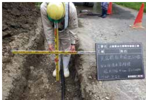
農業用水引き込み配管の補修
