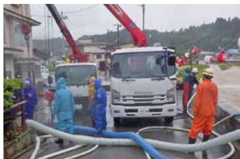
内水氾濫した地区の水をポンプで排水
