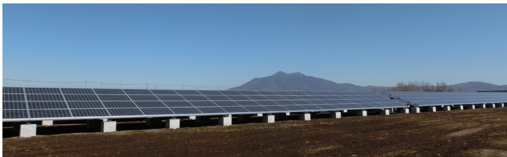
つくば太陽光発電施設
