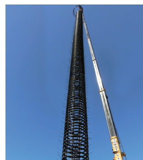
地中熱交換器設置状況
