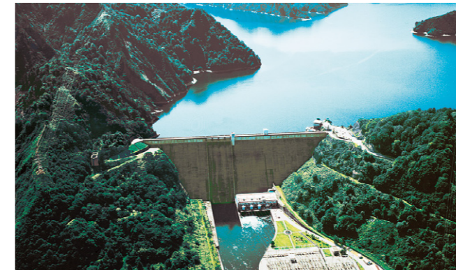
Tagokura Dam (Fukushima)
