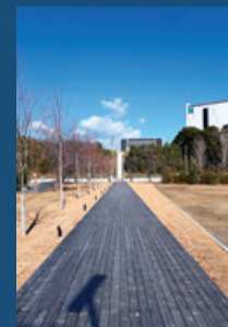
ケボニー材ウッドデッキ
