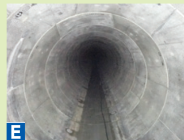
施設整備事業の内導水施設 国庫補助事業 豊平川水道水源水質保全 導水路新設工事その1
