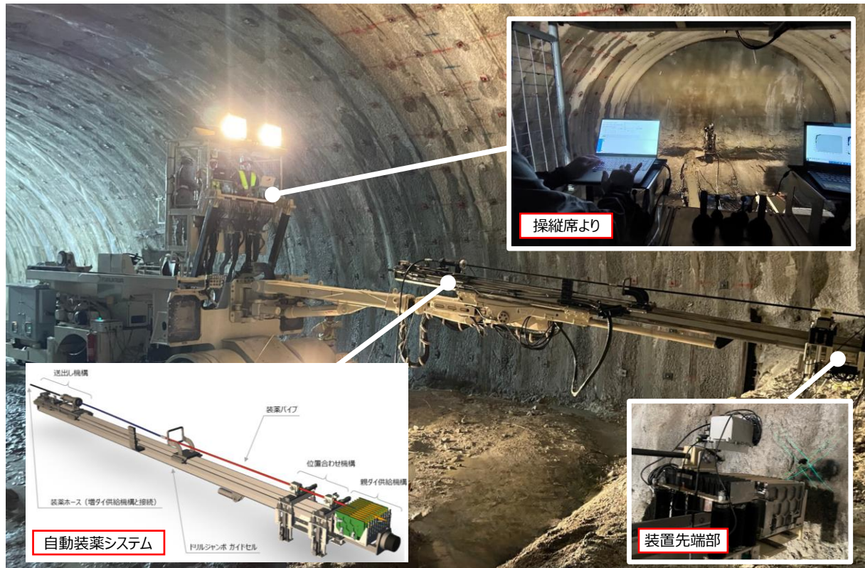
写真-1 無人の切羽で装薬作業を行う様子
