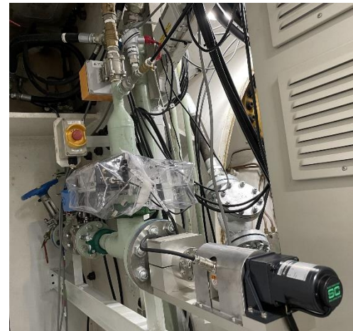
写真-2 シールドマシンに取り付けた様子
