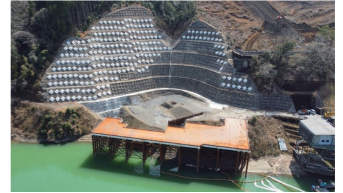
新丸山ダム転流工(岐阜県可児郡御嵩町)
