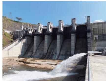
アッパーコトマレ水力発電所(スリランカ)
