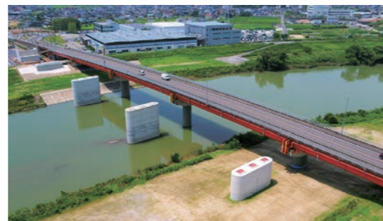
竜宮橋橋梁(愛知県豊田市)
