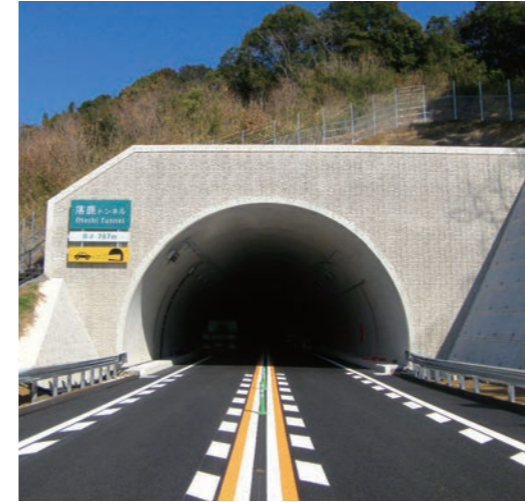
東九州自動車道 落鹿トンネル(宮崎県日向市)
