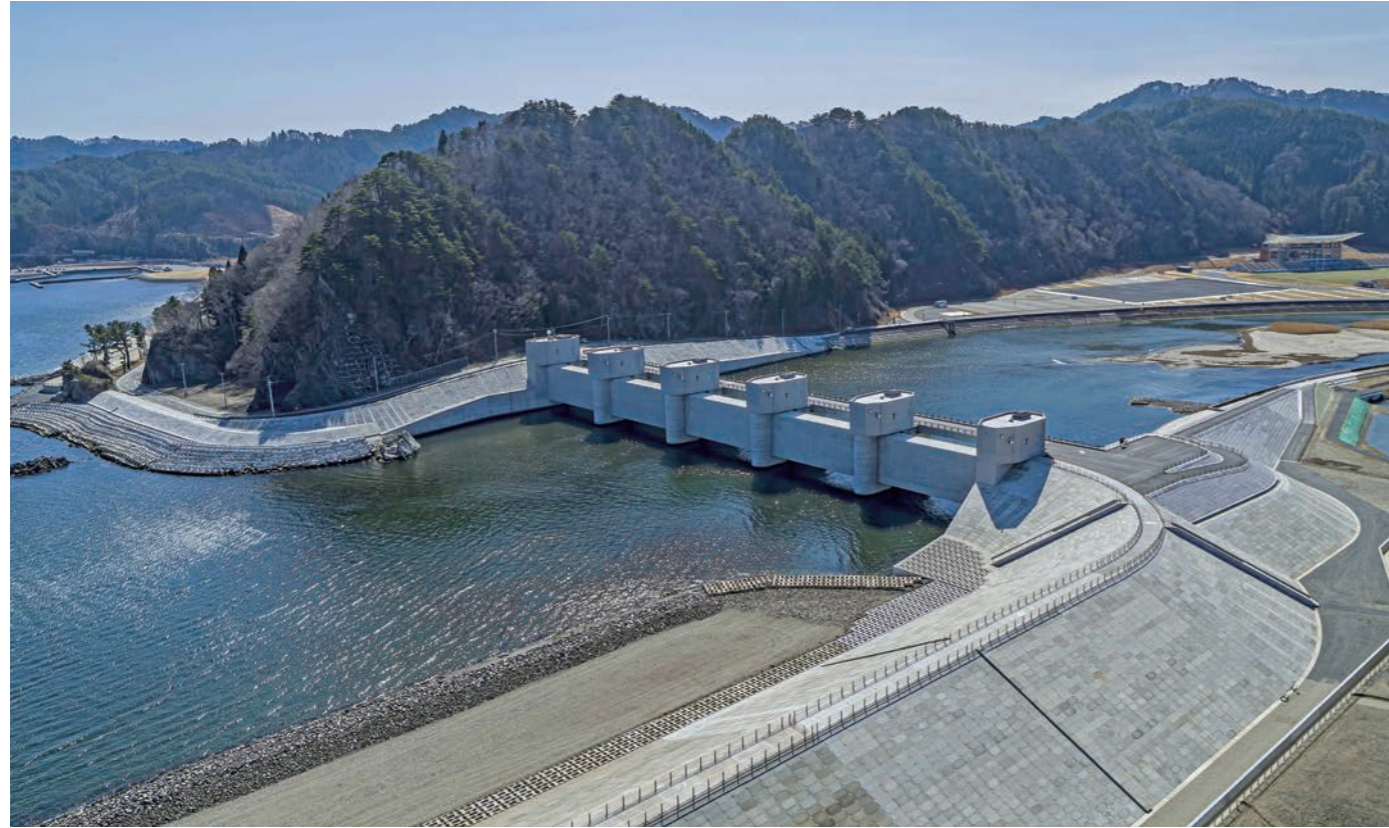
鶴住居地区河川災害復旧(岩手県釜石市)
