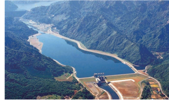
只見発電所(福島県南会津郡只見町)
