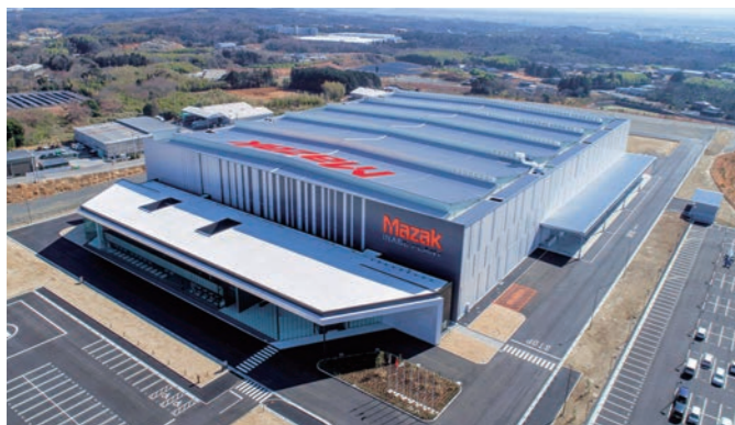
ヤマザキマザックいなべ製作所(三重県いなべ市)
