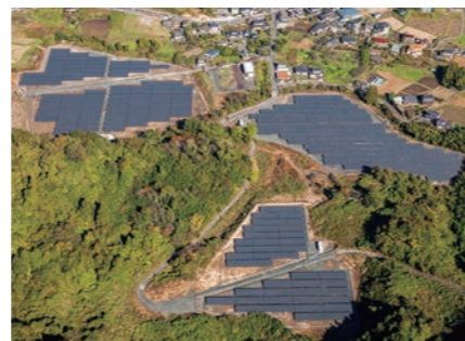
北茨城太陽光発電所(茨城県北茨城市)
