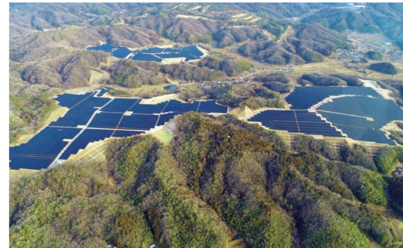
赤磐発電所(岡山県赤磐市)
