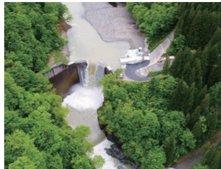
上結東水力発電所(新潟県中魚沼郡津南町)
