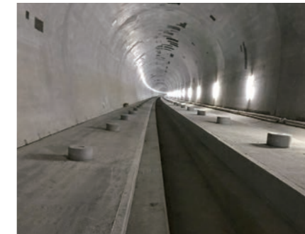
柿原トンネル(福井県あわら市)
