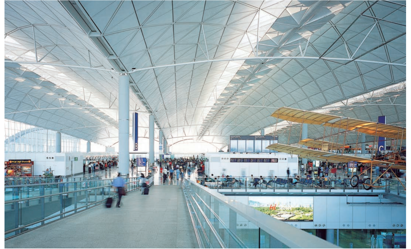
香港国際空港ターミナルビル(香港)
