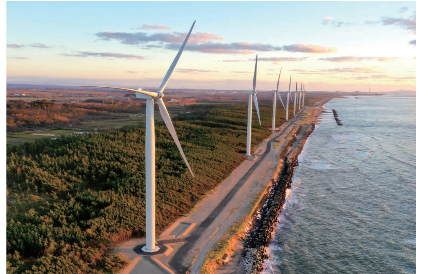
八峰風力発電所(秋田県山本郡八峰町)
