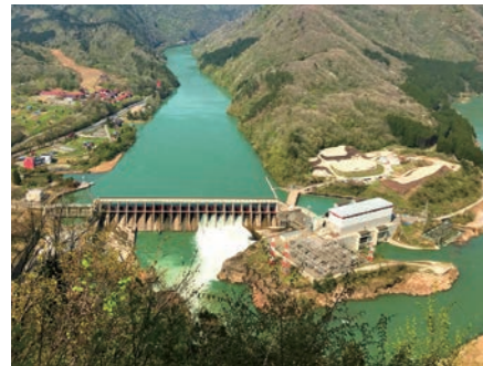
鹿瀬発電所(新潟県東蒲原郡阿賀町)
