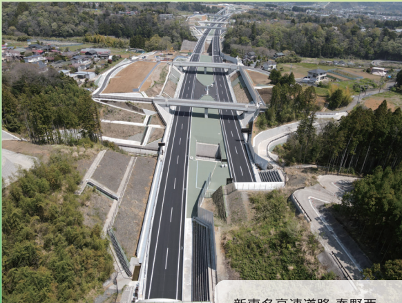
新東名高速道路 秦野西 (神奈川県秦野市) 新東名高速道路建設事業のうち、神奈川県秦野市域の総延長1,355m区間で切盛土工および下部工等を築造する工事。
