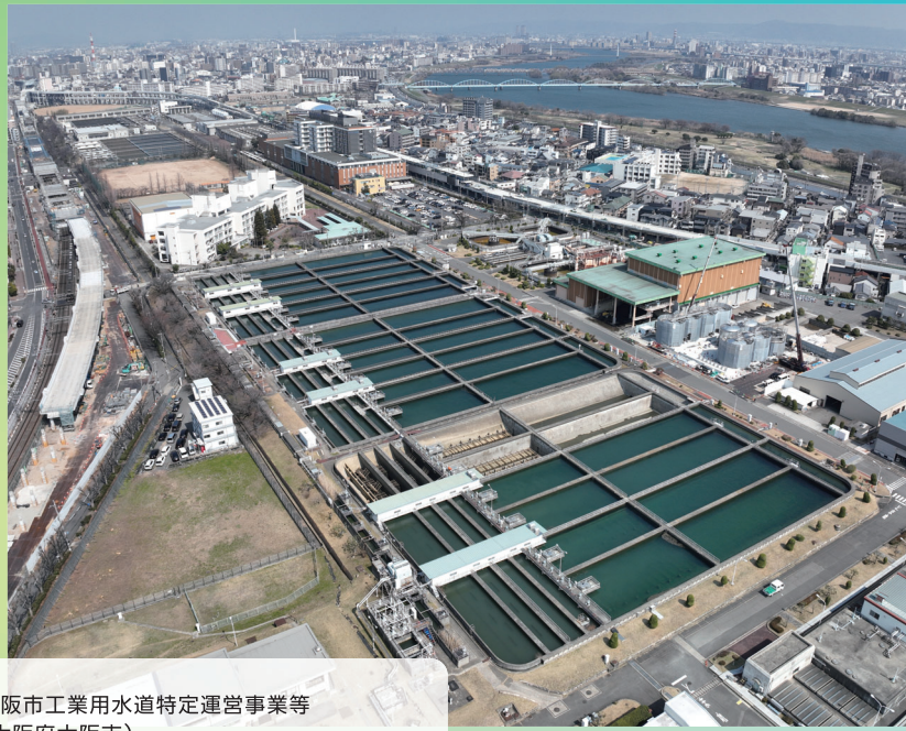
大阪市工業用水道特定運営事業等 (大阪府大阪市) 100年後も工業用水道を持続的に支える運営体制を目指し、ICT活用で漏水リスクを常時把握し、修繕・更新のバランスを最適化。
