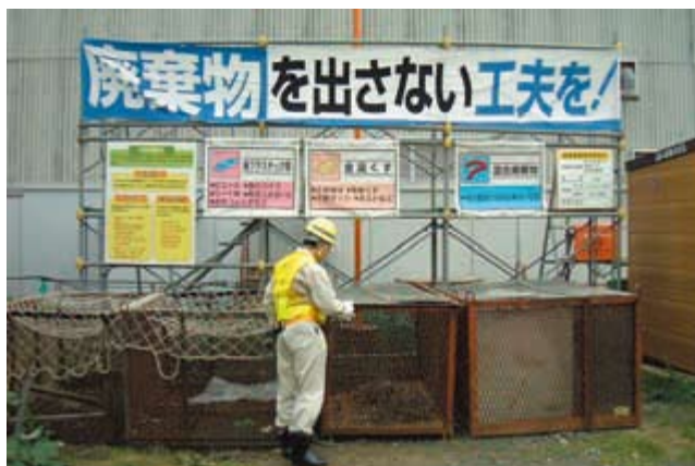
現場の分別ヤード
