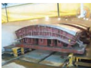
工場での養生状況
