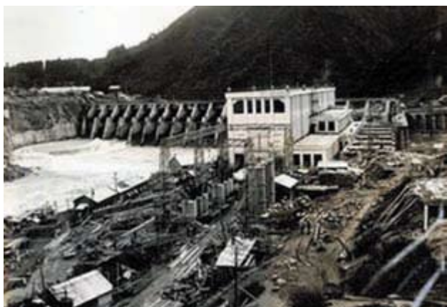
昭和2年当時の豊実発電所
