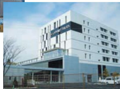
(株)ジャパネットたかた 本社屋 施工後
