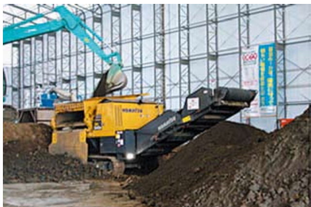
土壌汚染対策工事
