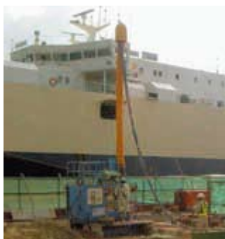
マルチジェット工法による改良工事
