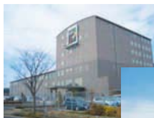
(株)ジャパネットたかた 本社屋 施工前
