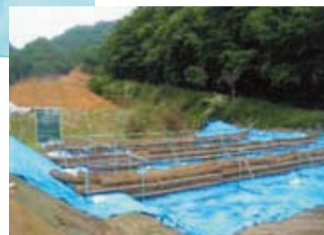
第2沈砂池の竹そだフィルター
