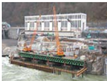
豊実発電所リニューアル工事状況
