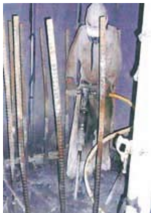
ハンドブレーカーでの作業
