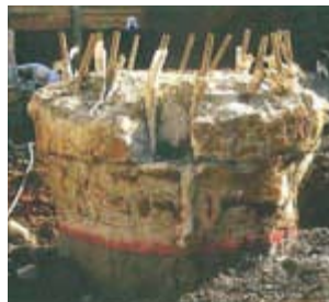
杭の上端部掘削完了後
