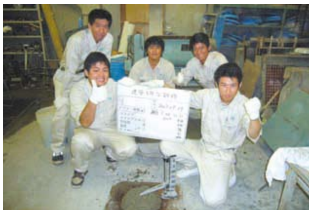
集合教育におけるコンクリート打設
