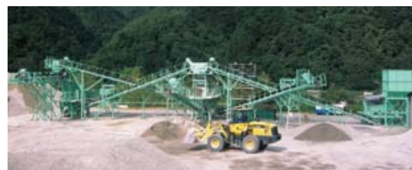
再生骨材製造 2次破碎工
