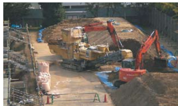
固化材投入時の粉塵発生が少ない工法を採用
