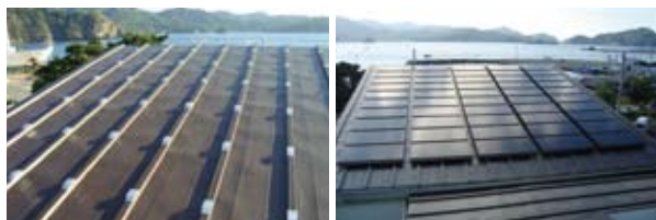
パネル設置前(左)と設置後(右)
