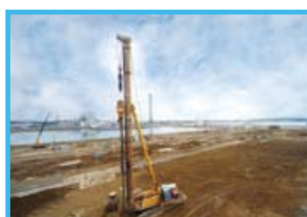
常陸那珂火力発電所:複数の工法を用いた地盤改良
