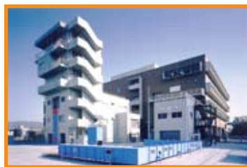
東大阪市消防局・中消防署庁舎:情報システム整備を含んだ全国初の消防署PFI事業
