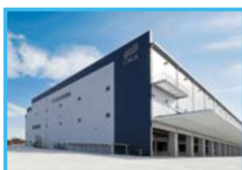
川越第二産業団地ロジスティクスセンター
