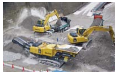
再生骨材製造 1次破碎工
