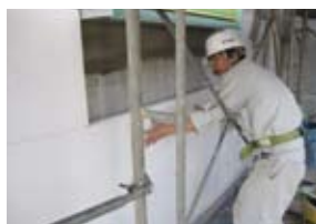
吉祥寺M作業所における外断熱材設置状況
