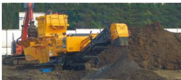
生石灰による油汚染土の処理
