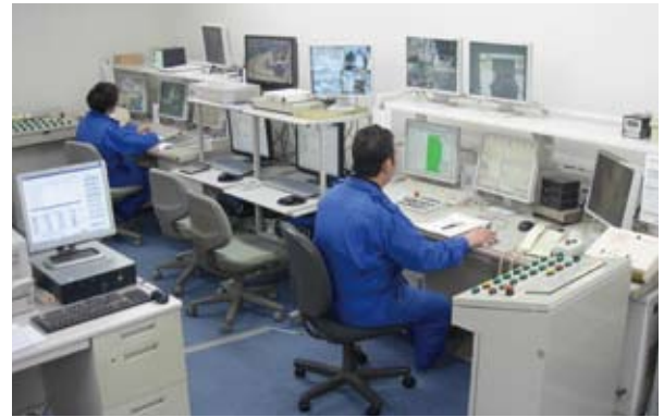
コンクリート製造操作室および試験室
