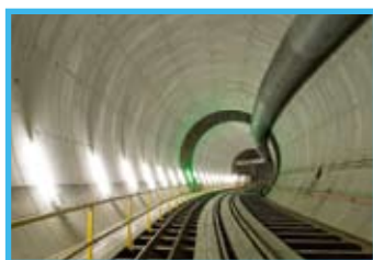
立会川シールド:コッター・ウィックジョイントセグメント
