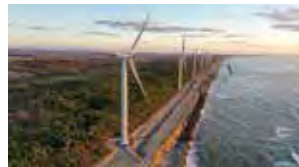
八峰風力発電所
