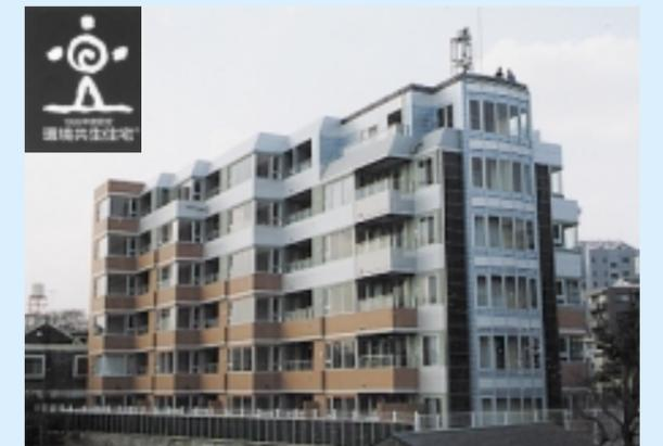
定量効果としては、外壁高断熱化、屋上緑化、太陽光発電などの採用により、運用時の冷暖房・照明使用に伴うCO<sub>2</sub>排出量は1住戸に換算すると約4%削減されました。
