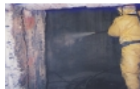
煙突内部の洗浄
