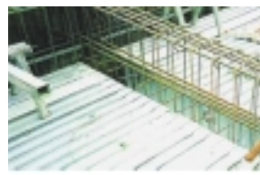
梁筋組立状況
