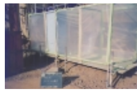
クリーンルームの設置
