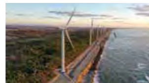
八峰風力発電所
