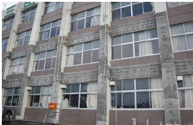
ディスクアンカー打設状況
