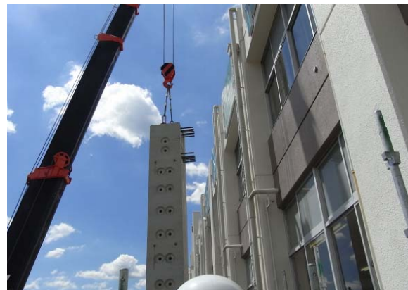
PC部材取付状況
