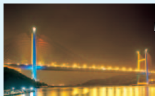
【汲水門（カプスイモン）大橋】 1997年完成し、優れた特色を有する橋梁に与えられる土木学会「田中賞」を受賞
