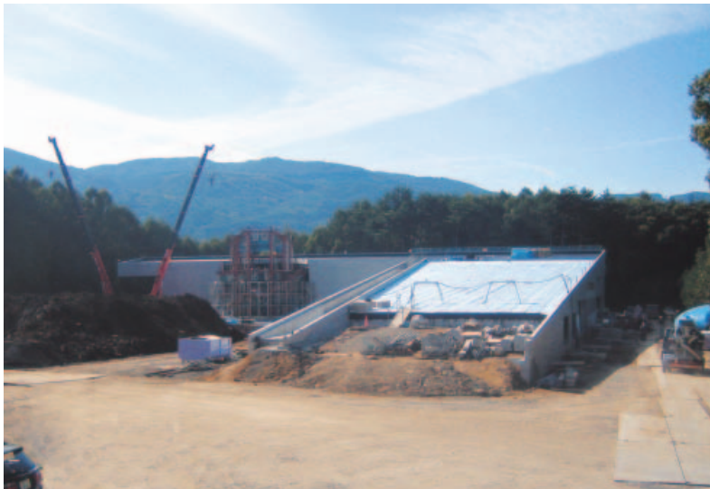
施工中の写真
