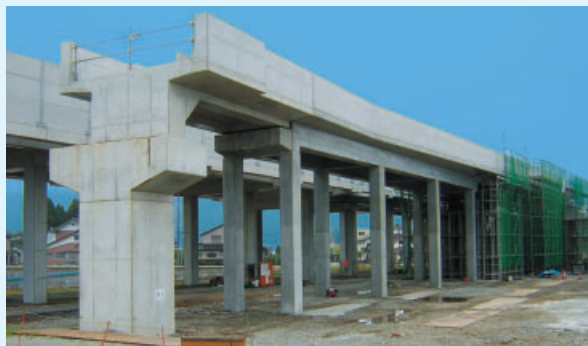
施工中の写真
