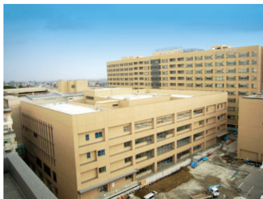
平成20年10月現在の施工状況
