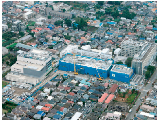
平成22年10月末 施工中工事写真（北西面全景）
