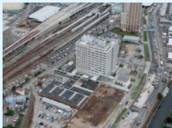
発注者：九州地方整備局 熊本合同庁舎A棟建築工事
