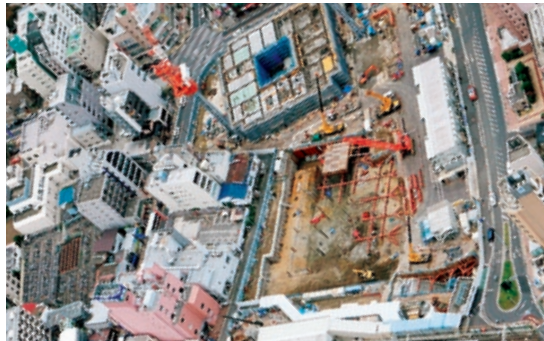
施工中工事写真（平成23年10月末撮影）
