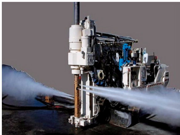
マルチジェット工法 氣中噴射状況
