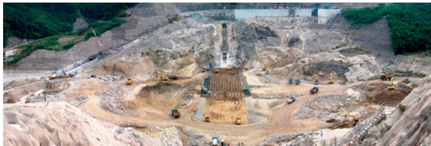
施工中工事写真（平成24年10月堤体より撮影）
