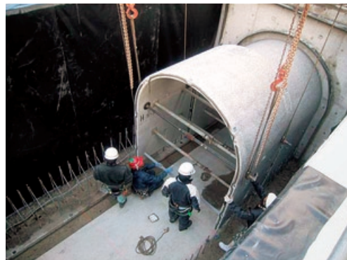
管理用通路のプレキャスト型枠施工状況
