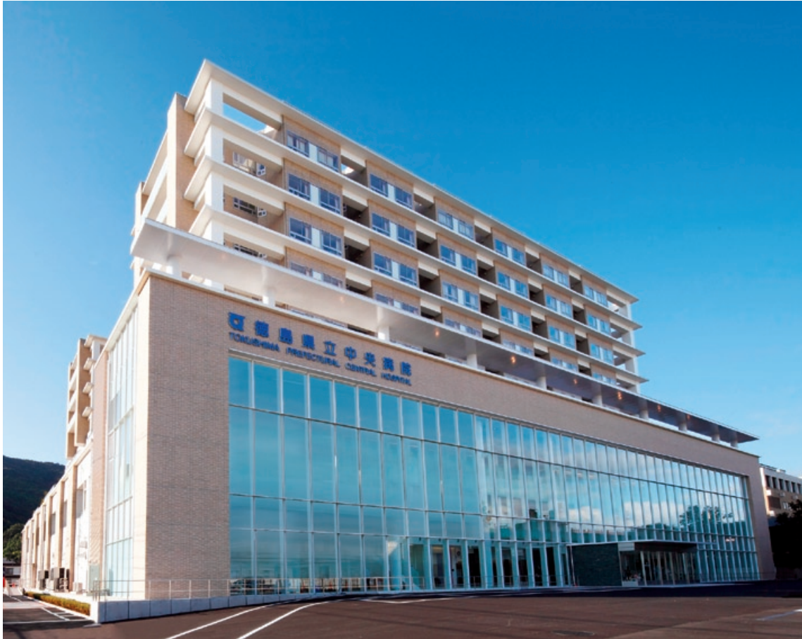
徳島県立中央病院改築工事のうち建築工事
