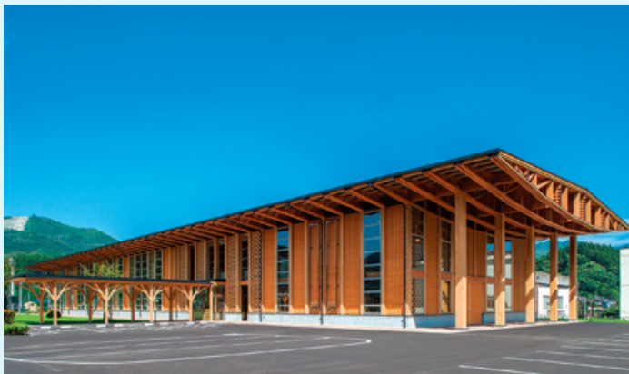
住田町役場の外観
