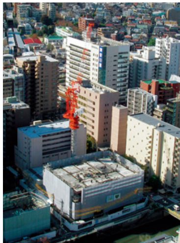
平成27年11月撮影 施工中工事写真
