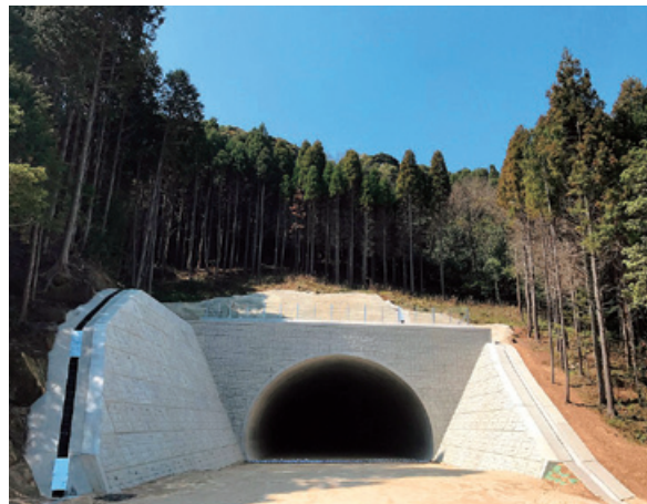
長崎497号 調川トンネル1号新設工事（長崎県）
