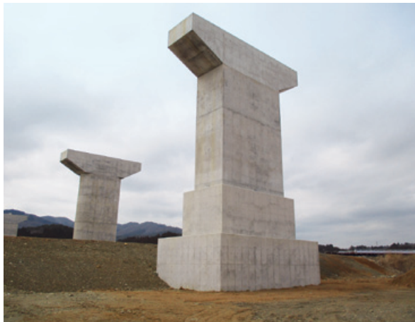
国道45号 津谷川橋下部工工事（宮城県）
