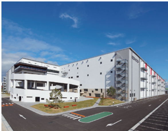
(仮称) レッドウッド南港ディストリビューションセンター1新築工事（大阪府）
