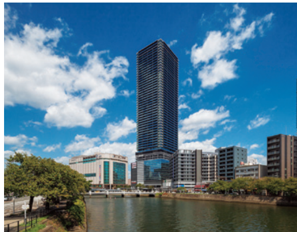
広島駅南口Bブロック第一種市街地再開発事業 施設建築物新築工事（広島県）
