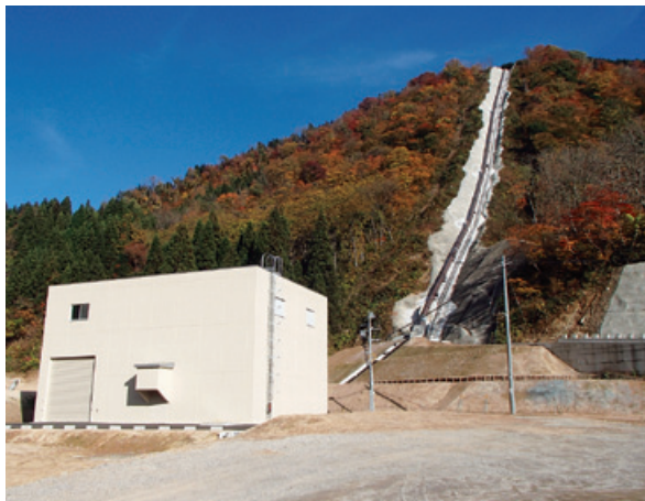
片貝別又発電所新設工事のうち土木本工事（富山県）
