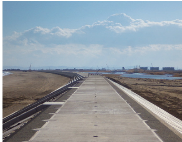
仙台湾南部海岸深沼南工区井土浦地区堤防復旧工事（宮城県）
