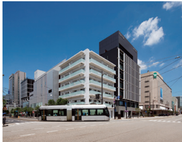
総曲輪西地区第一種市街地再開発事業施設建築物新築工事施工業務及び外構工事施工業務（富山県）
