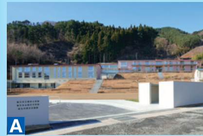
釜石市 唐丹地区学校等 建設工事
