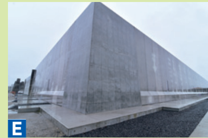
宮古港海岸 藤原地区 防潮堤その4工事
