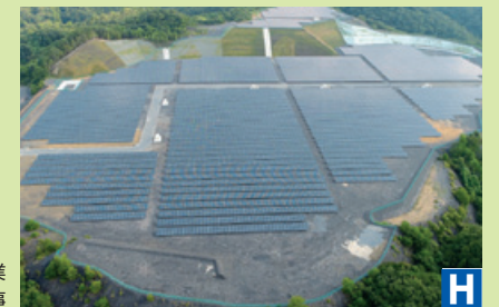
美祢太陽光発電事業 建設工事
