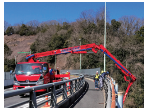
山間部橋梁の上部から床版下面を観察
