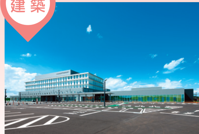
新中核病院建設工事 (茨城県)
