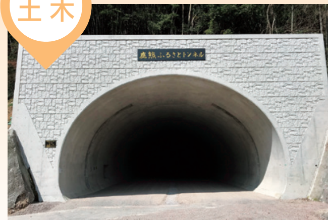
平成26年度道改国第2号中津3号トンネル工事 (1工区) (大分県)
