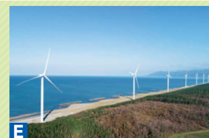
八峰風力発電所 建設工事
