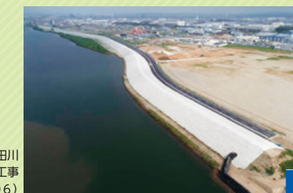
次期廃棄物埋立場 埋立地整備工事
