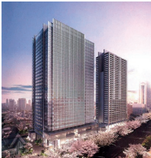
飯田橋駅西口地区第一種市街地再開発事業の完成予想図です。本年4月より着工し、平成27年の完成を目指しています。
