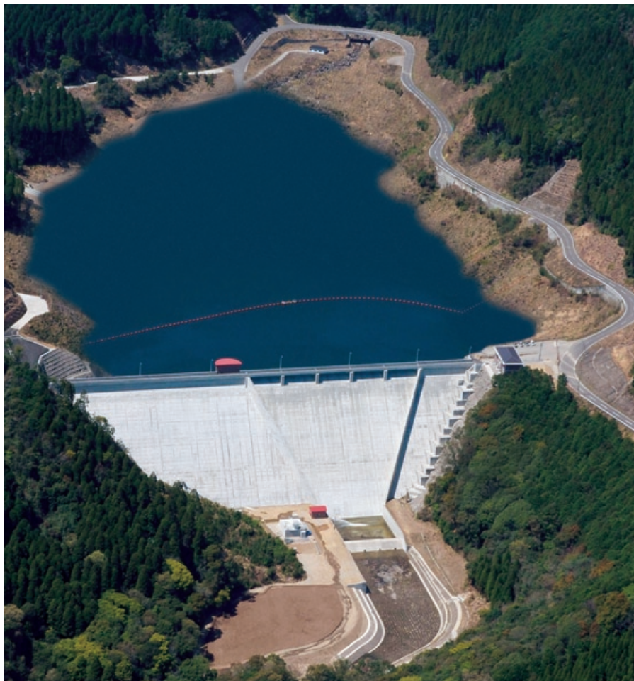
農林水産省九州農政局／尾鈴農業水利事業 切原ダム 第二期建設工事（宮崎県）
