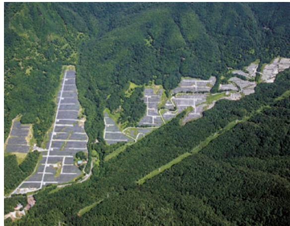
五葉山太陽光発電事業 発電所建設工事
