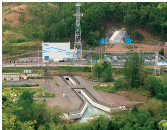
新岩松発電所新設工事のうち土木本工事
