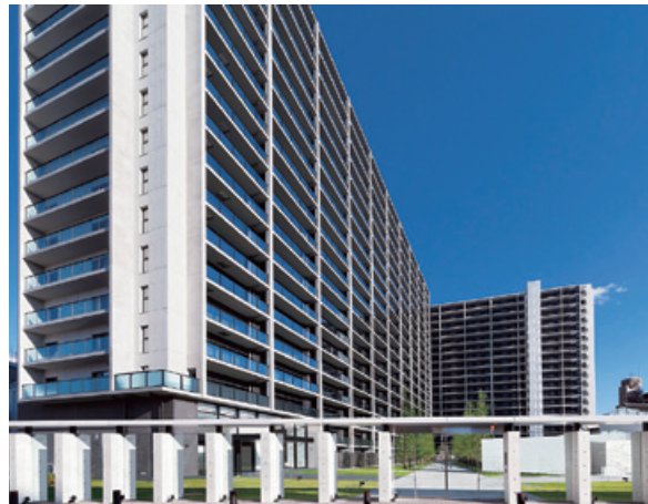
（仮称）悲田院計画新築工事 （「ザ・天王寺レジデンスガーデン&ビスタ」）
