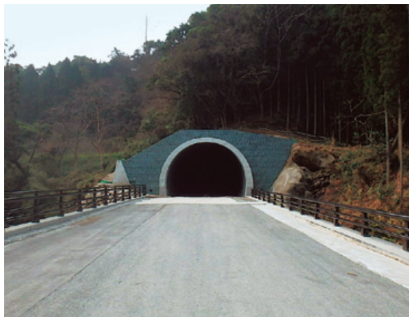
福岡322号 八丁峠道路トンネル（嘉麻側）新設工事
