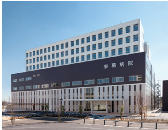
東葛病院移転新築工事
