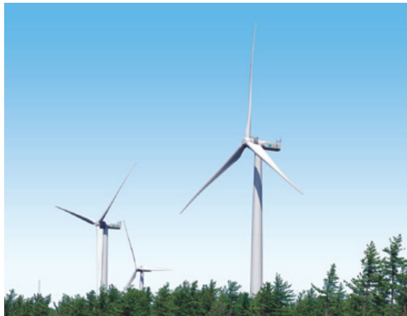
吹越台地風力発電所施設建設工事
