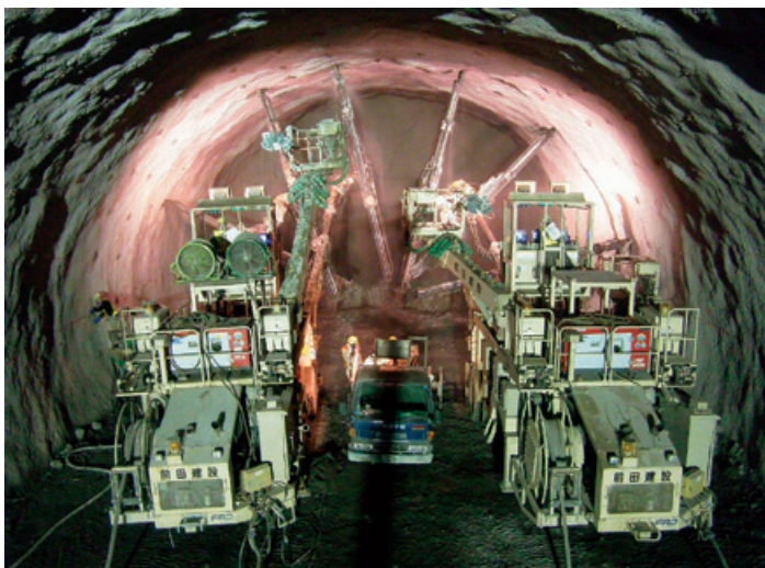
国道45号 新鍬台トンネル工事
