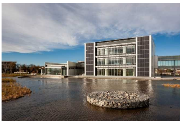
エクステンジ棟 南側水景より
