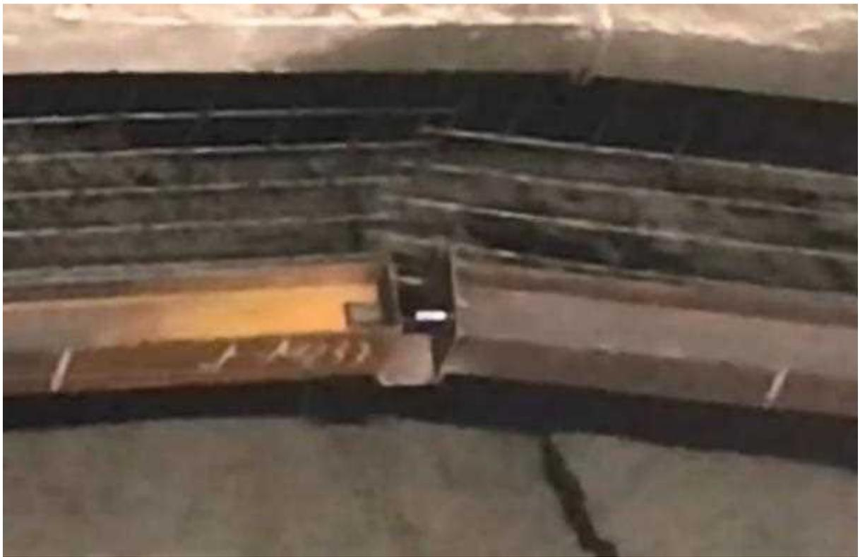
図3 ワンタッチ式クイックジョイントによる天端継手
