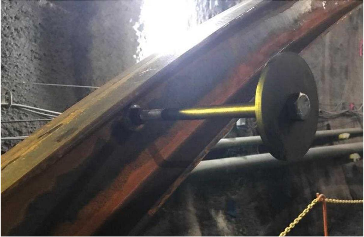
図5 転倒防止用アンカーを事前に固定
