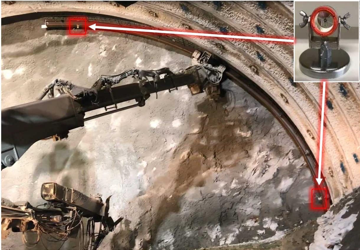
図7 鋼製支保工へのプリズム設置と位置合わせ状況
