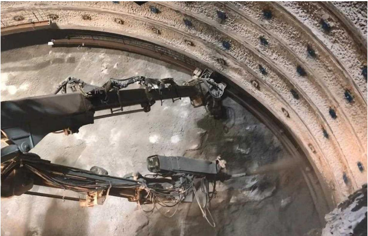
図6 エレクターにて把持しながら吹付けコンクリートを施工
