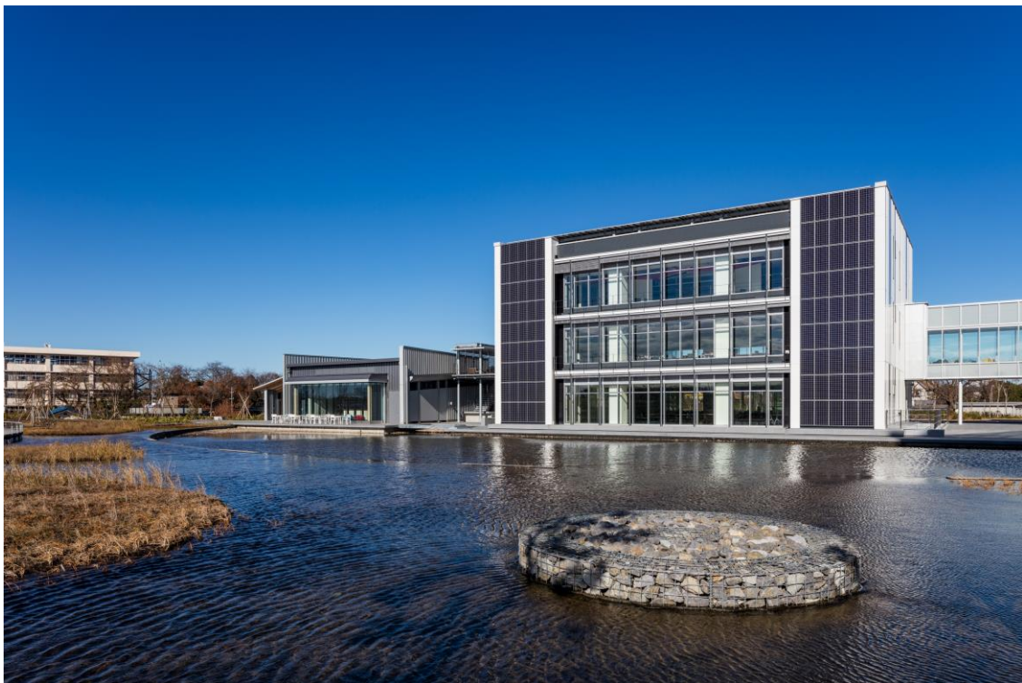
ICI LAB エクスチェンジ棟
