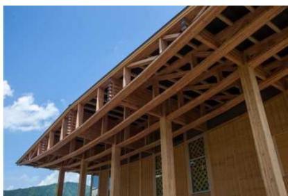
レンズ型のトラス梁と柱が外部に露出する
