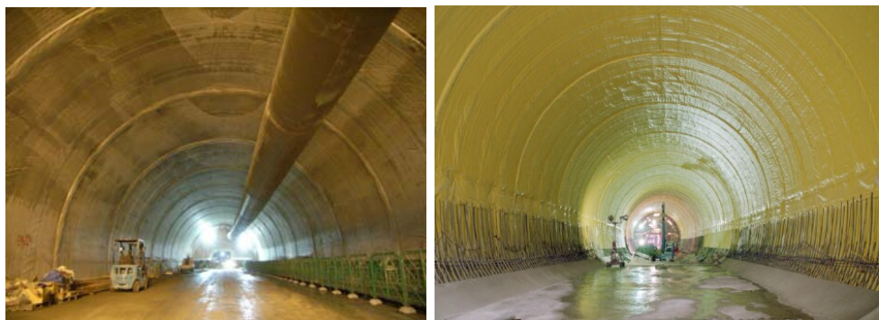
鉄 道 ト ン ネ ル
