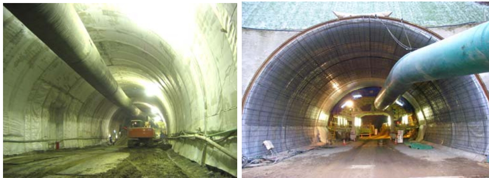
道 路 ト ン ネ ル
