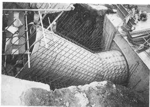
写真-5 設置が完了したPCa型枠(斜面部)
