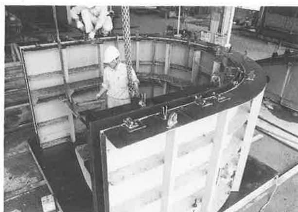
写真-1 PCa型枠の製造状況
