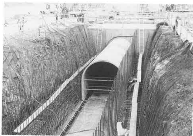
写真-4 設置が完了したPCa型枠(水平部)
