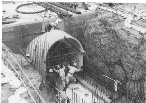
写真-3 PCa型枠の設置状況
