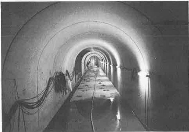
写真-7 完成した監査廊の内部状況
