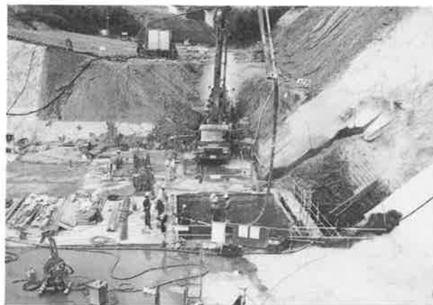
写真-6 コンクリートの打設状況
