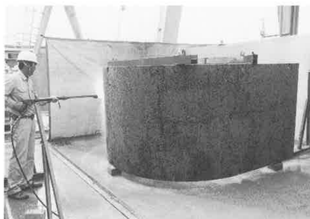
写真-2 外周面の洗い出し状況
