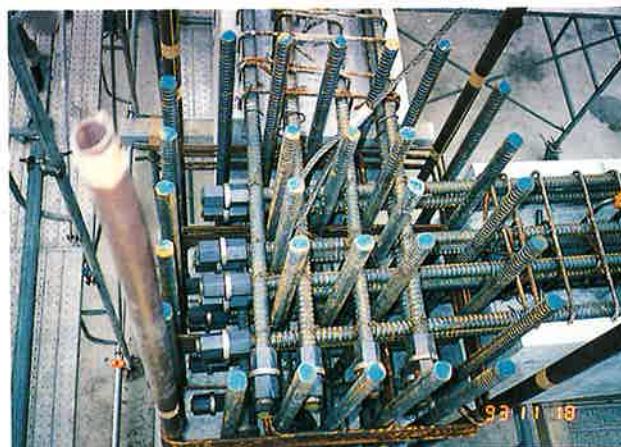
写真-1 梁主筋のプレート定着工法の例
