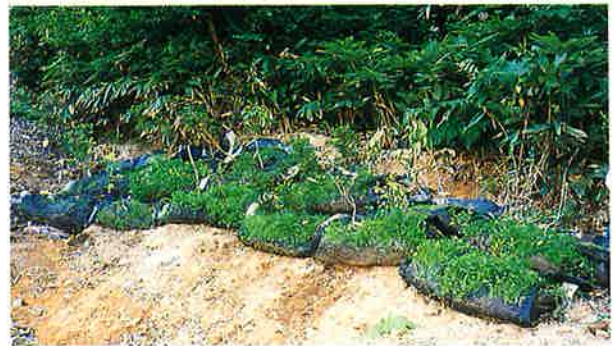
写真 8 Tダム設置直後
