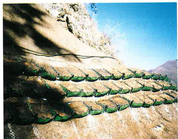
写真 11 Kダム試験全景
