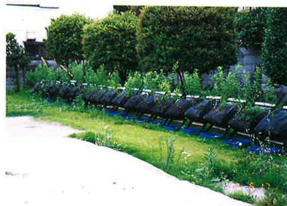
写真 3 植生ユニット設置状況
