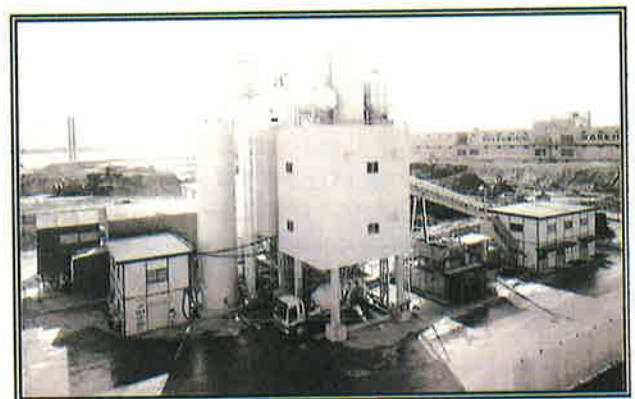
写真-1 新港流動化処理プラントの全景（後方は、建設発生土の仮置きヤード）
