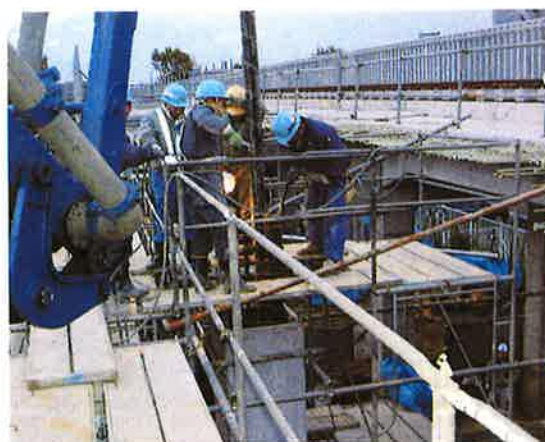
写真-2 コンクリート打設状況
