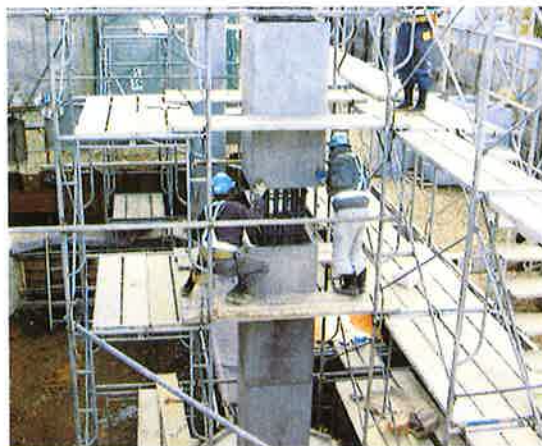
写真-1 プレキャスト型枠建て込み状況
