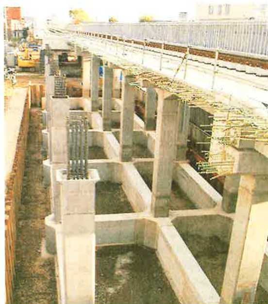
写真-3 完成（地中梁埋め戻し前）
