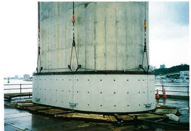
写真-5 リングの沈設
