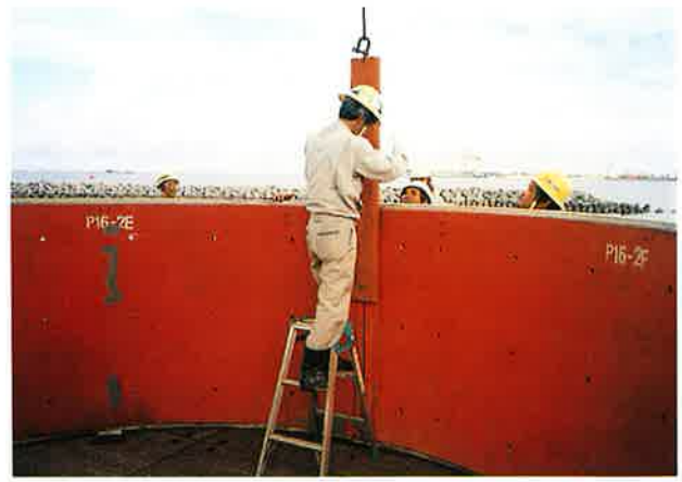
写真-4 継手挿入状況
