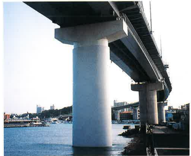
写真-2 P16橋脚補強完了状況
