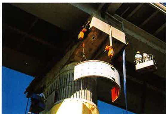
写真-7 気中部パネルの組立
