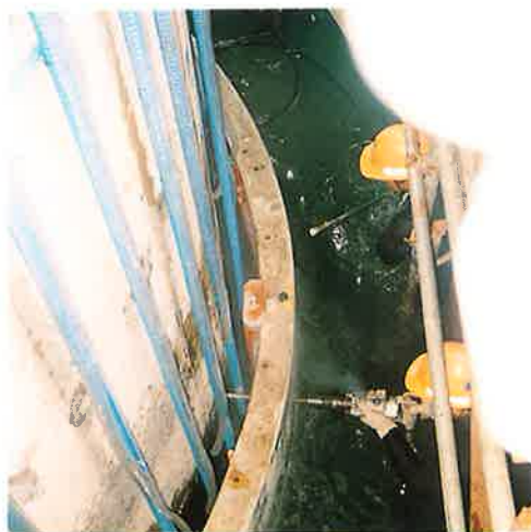
写真-6 変形防止アンカーの施工
