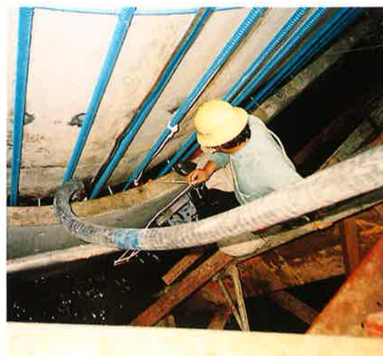
写真-8 水中部グラウト状況
