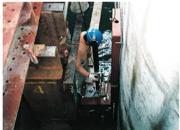
写真-3 削孔状況
