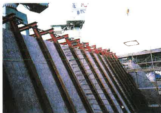
写真-9 遊水室背面突起付きH形鋼設置状況
