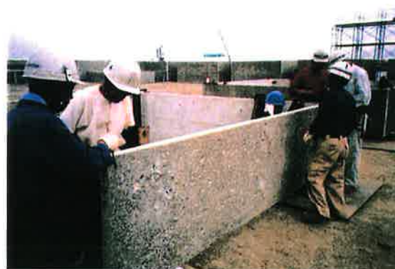
写真-2 RCプレキャスト埋設型枠組立て状況
