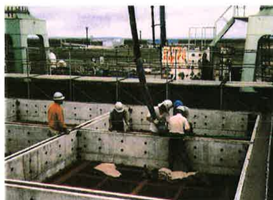
写真-6 流動コンクリート打設状況
