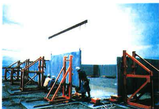
写真-1 高耐久性埋設型枠組立て状況
