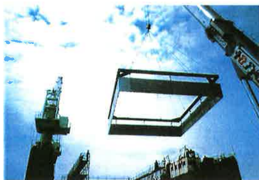
写真-3 高耐久性埋設型枠設置状況
