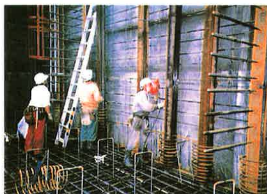
写真-4 突起付きH形鋼設置状況
