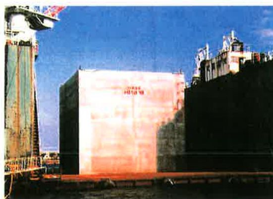
写真-7 防波堤ケーソンの完成
