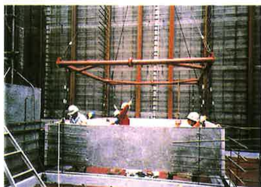
写真-5 RCプレキャスト埋設型枠設置状況
